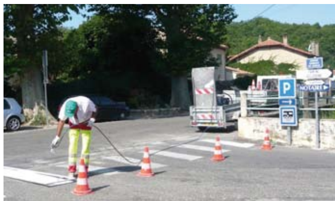
REPRISE DES MARQUAGES AU SOL.
